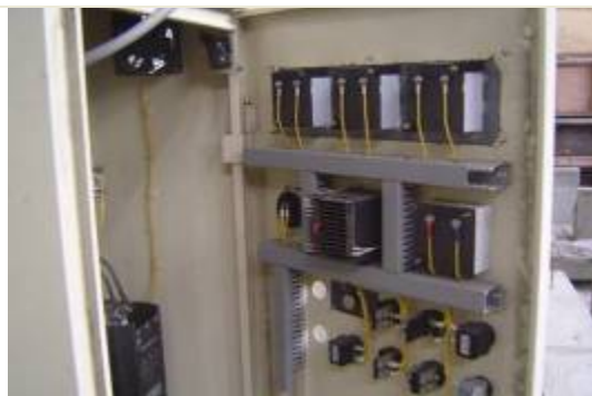
電線接頭並無防止感電裝置
