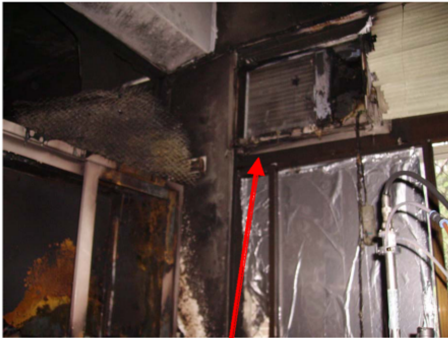
冷氣機及冷氣機下方開關燒燬情形
